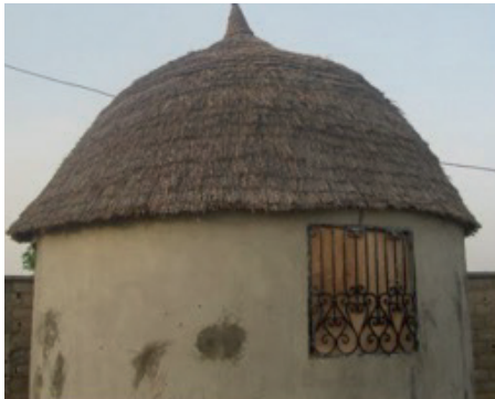
Photo 10 : Fenêtre avec protection sur une case Tupuri
